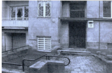
Іл. 3. Кована декоративна віконна решітка. м. Львів, вул. Котлярська, 17
